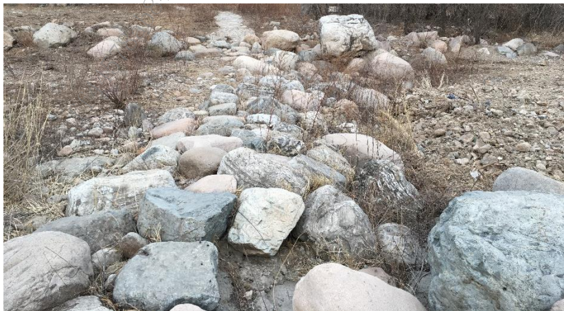
图 4-38 现状溢流坝照片
